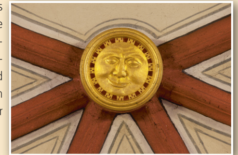
Schlussstein des Kreuzrippengewölbes
