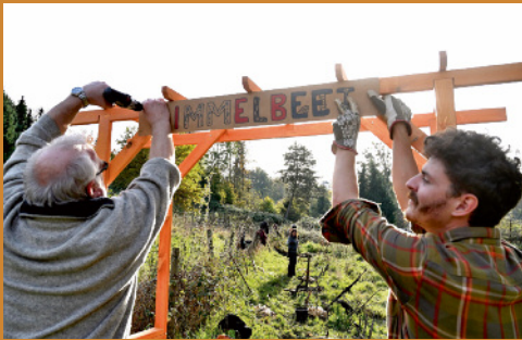
Errichtung des Eingangstors
